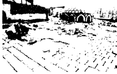
مشروع صيانة وترميم سطح جامع الجوادين
